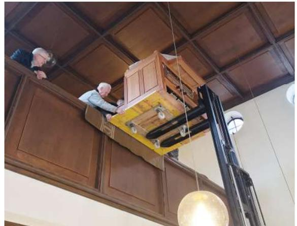
Es handelt sich um eine mechanische Pfeifenorgel mit Pfeifenwerk, Windladen (Schleifen- und Tonkzellenladen), mechanische Spiel- und Registertraktur, Windanlage (elektrischer Ventilator) und Orgelgehäuse, alles aus hochwertigen und edlen Materialien (Eichen- und Fichtenholz, bestes Schafsfleder, Föhren- und Lärchenholz für die Holzpfeifen, eine Zinn- Bleilegierung für die Metallpfeifen, Gehäuse massiv Lärche).
